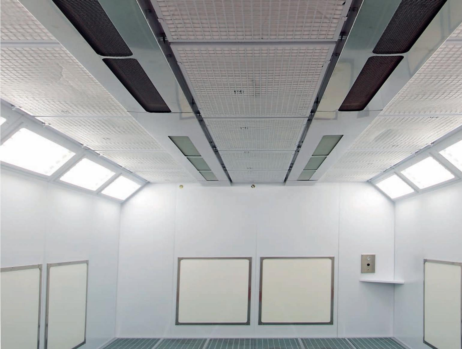
Los paneles endotérmicos **Helios** pueden ser instalados en cualquier cabina de pintura, pudiendo plantearse diferentes configuraciones para adaptarse a cada cabina y según necesidades, teniendo en cuenta, por ejemplo, la disposición de las luces de la cabina (plafones únicamente en lo alto de las paredes laterales o también en los laterales) y si se montan también paneles en el techo.
